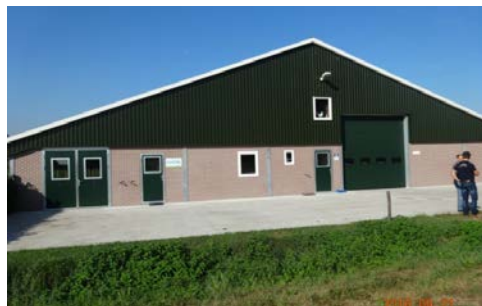
写真10 新設の第2鶏舎 鶏舎左にある両扉がウインターガーデンの入り口。
